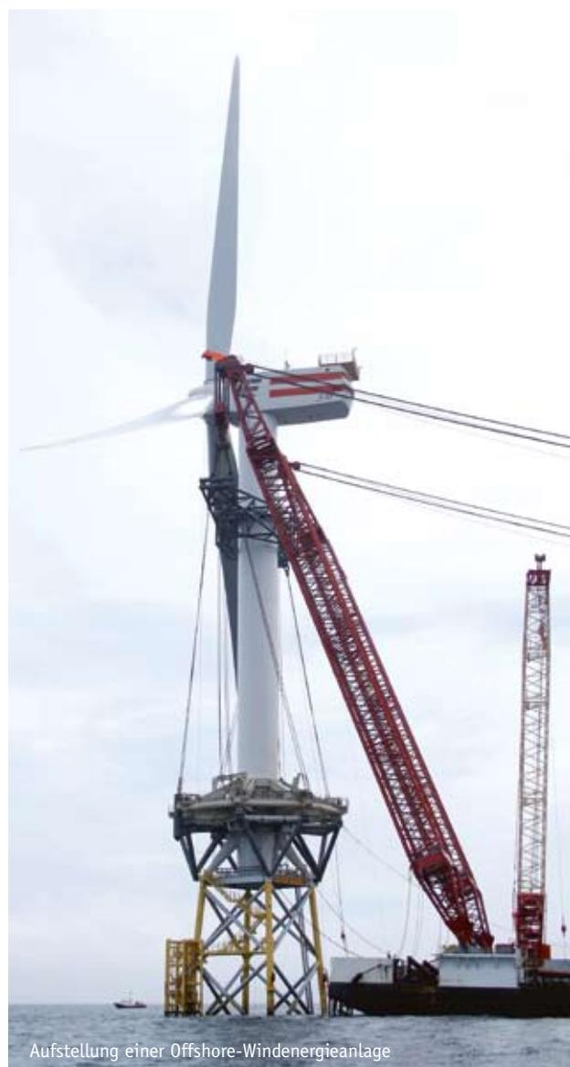
Aufstellung einer Offshore-Windenergieanlage
