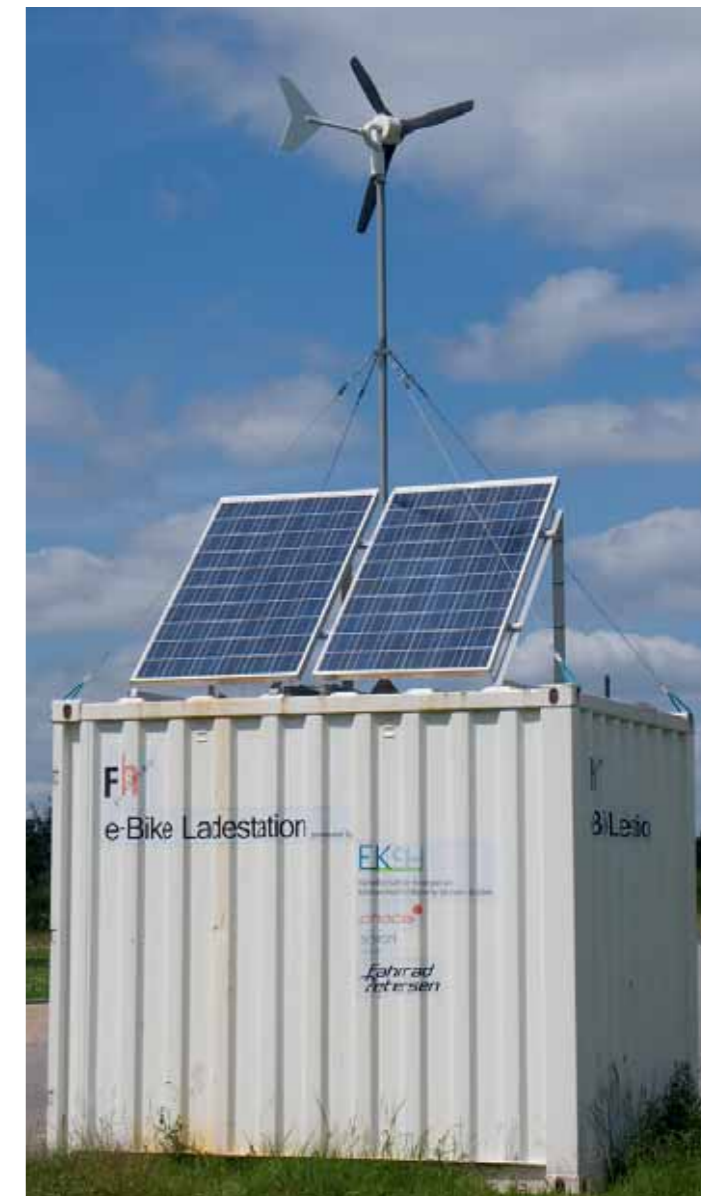
Elektroladestation: Hier bekommen E-Bikes Power aus regenerativen Energien. Foto: FH Flensburg
