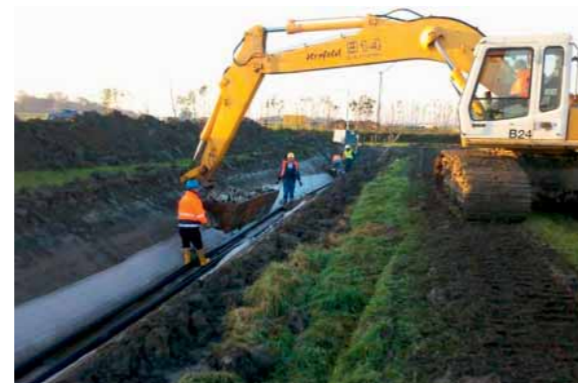
Verlegung der Erdkabel, die auf Geotextil gelagert worden sind, da der Untergrund zu weich ist. Fotos: Dr. S. Gebhardt
