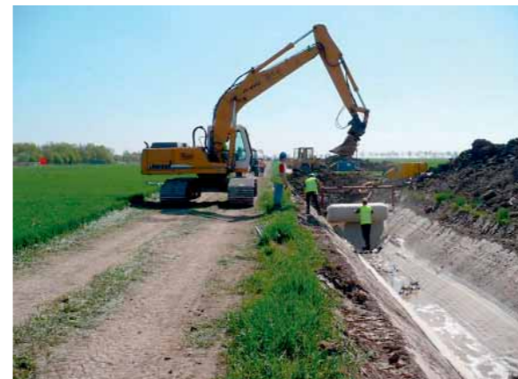
Vorbereitung des Grabens zur Verlegung des Erdkabels.
