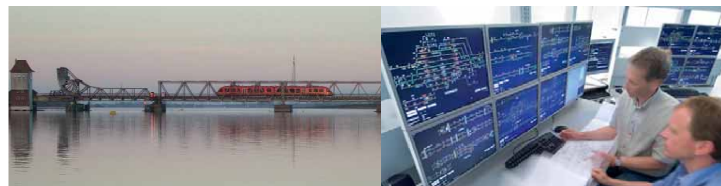
Für eine neue Generation elektronischer Stellwerke im Bahnverkehr: Im Verbundprojekt KoSSE-MENGES arbeitet das Institut für Informatik mit den Unternehmen Funkwerk IT und b+m Informatik zusammen. Fotos: Funkwerk IT
