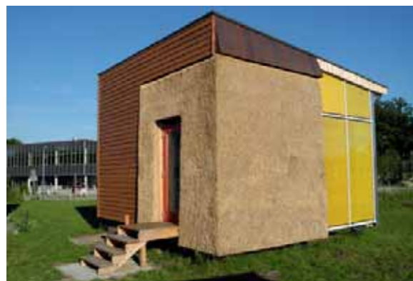
Regionalhaus aus 100 % nachwachsenden Rohstoffen auf dem Gelände der FH.
